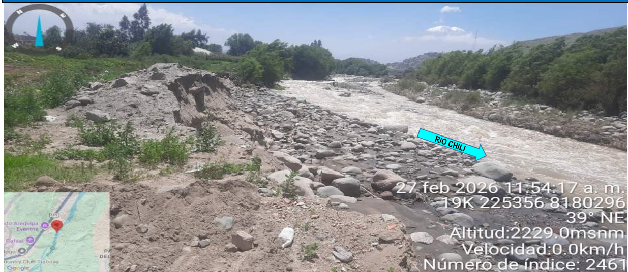
FIGURA N°01: SE MUESTRA AGUAS ABAJO, MARGEN DERECHA DEL RIO CHILI, QUE SE ENCUENTRA SOCAVADO Y COLMATADO CON MATERIAL PROPIO, SIN PROTECCIÓN EN LOS CULTIVOS; Y CON UN INCREMENTO DE CAUDAL DEL RÍO CHILI.
